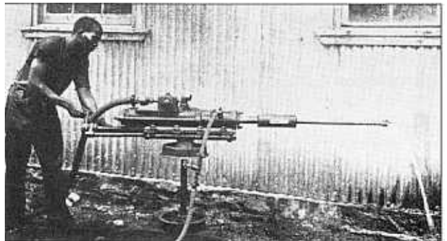
'n Meganiese rotsboor met watertoevoer deur die boorpunt.
