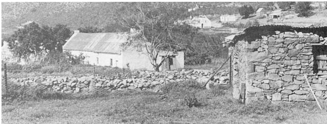
Die oudste huis op Braamrivier, in ca. 1815 deur H.M. Gerber (1768-1822) gebou. Op die voorgrond is die klipkraal en 'n gedeelte van die waenhuis-stal-kompleks sigbaar.
