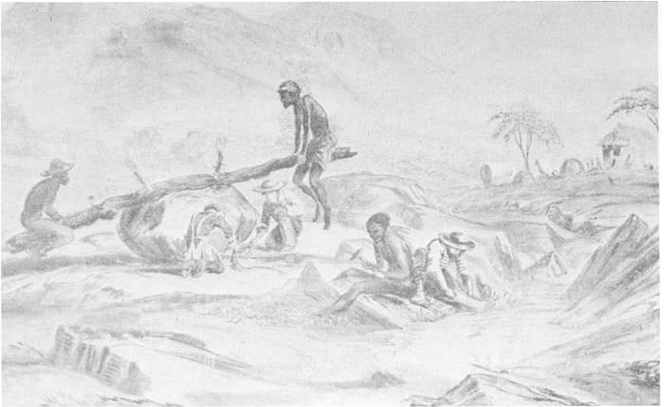
Twee Swartes ry wipplank op 'n rots voorsien van 'n dwarsbalk om die gouddraende erts fyn te maal. Dié toneel is deur Thomas Baines in die jare 1872—1873 geskilder.
